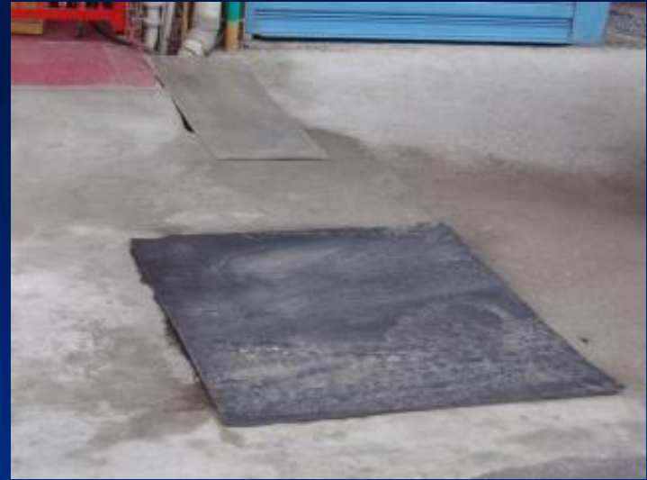
水溝蓋加裝細紗網或覆蓋塑膠軟墊
