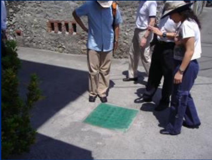
水溝蓋加裝細紗網或覆蓋塑膠軟墊
